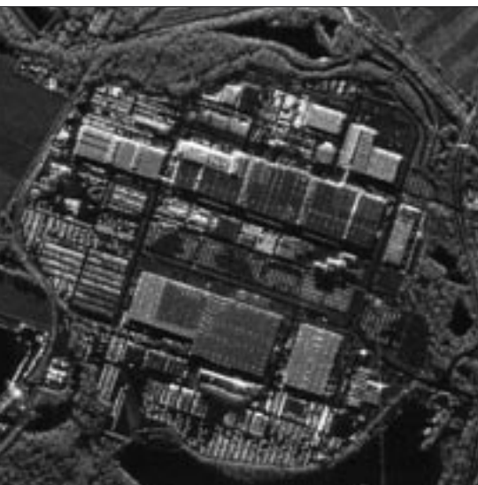
Imagen simulada del TerraSAR-X: Instalación de producción de vehículos de carga en Alemania (Imágenes DO-SAR, 1m de resolución)
